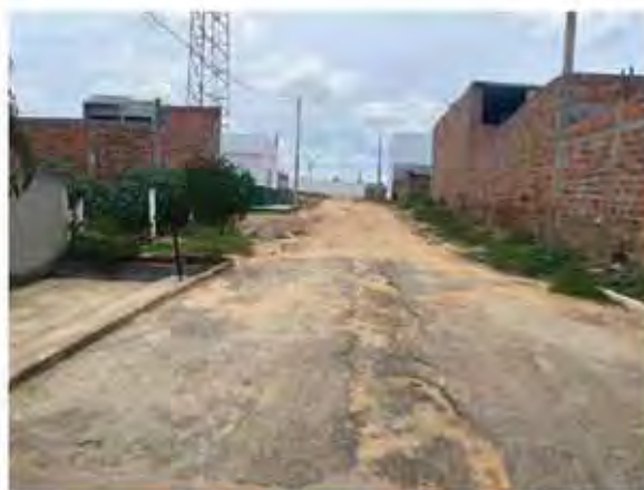
ESTACAS E0 a E03
