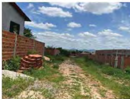
ESTACAS E03 a E04
