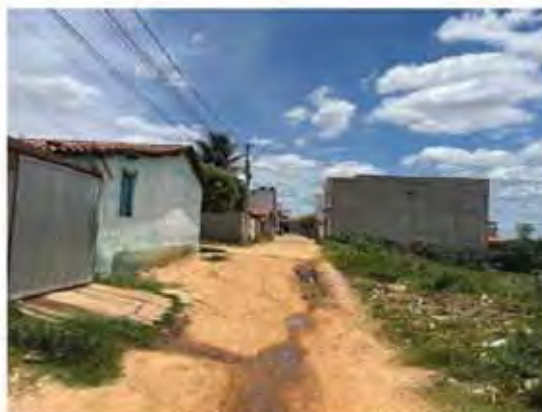
ESTACAS E19 a E21
