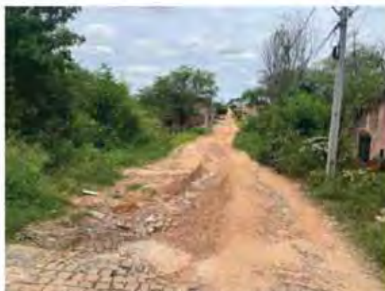
ESTACAS E0 a E01
