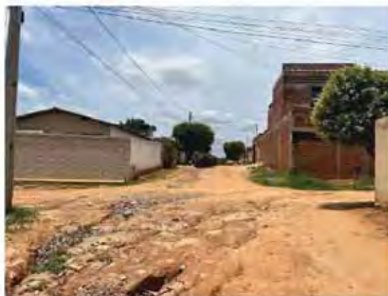
ESTACAS E07 a E09
