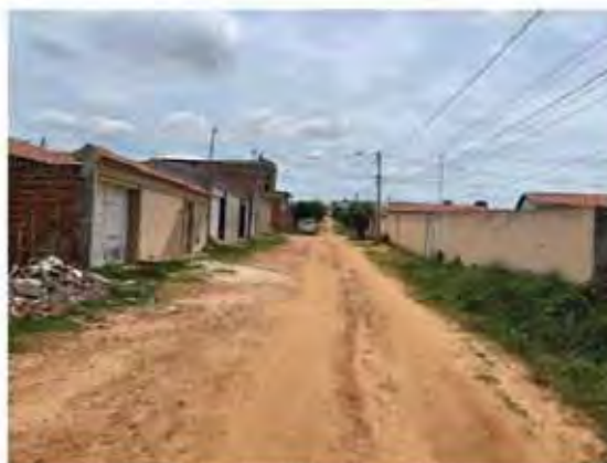
ESTACAS E02 a E03
