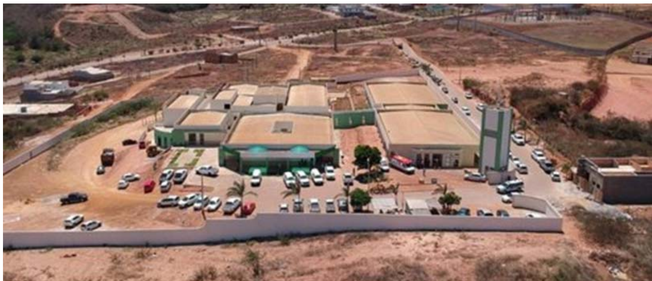
A unidade, que está com mais de 90% das obras concluídas, irá beneficiar moradores de 48 municípios do sudoeste baiano
